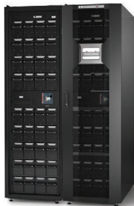
Armario de baterías con puerta abierta y cerrada.
