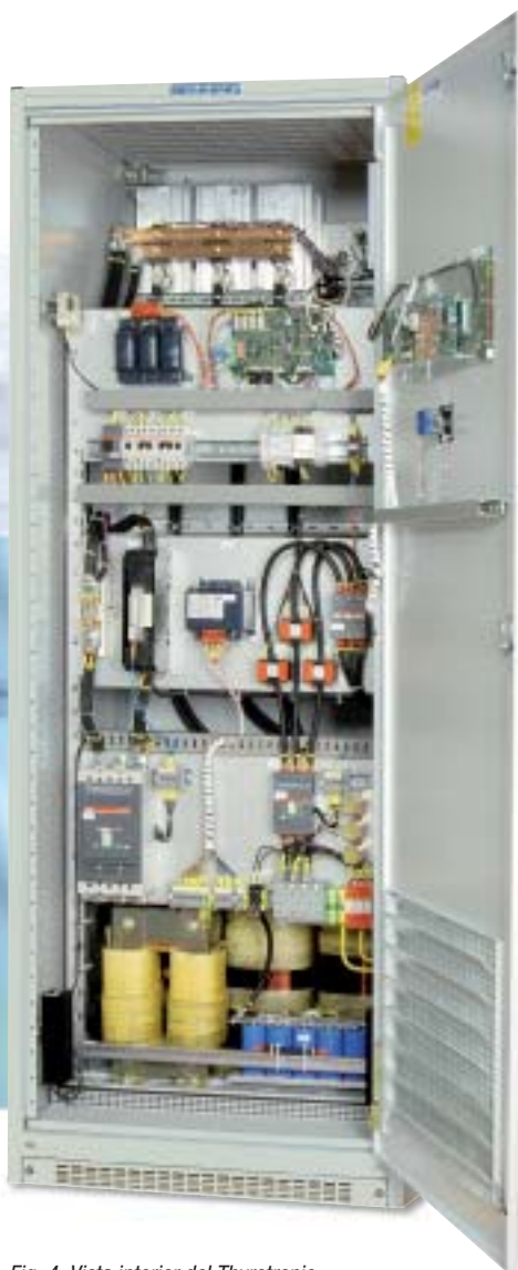
Fig. 4: Vista interior del Thyrotronic
